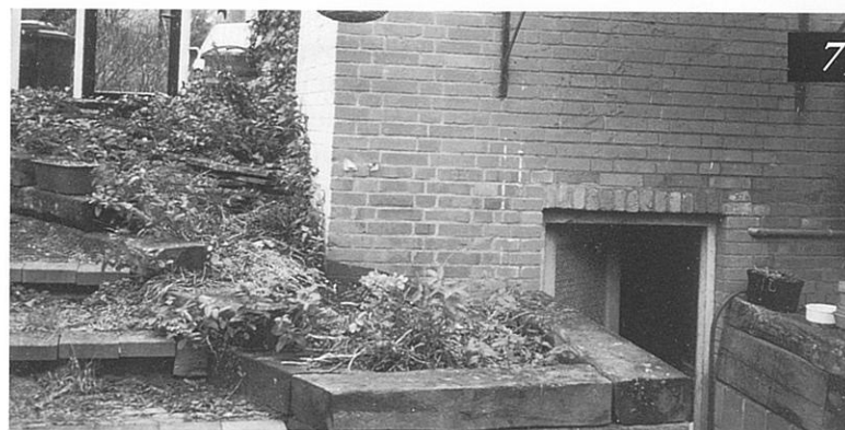
Betonnen kelder in de Laan van Leeuwesteyn.
