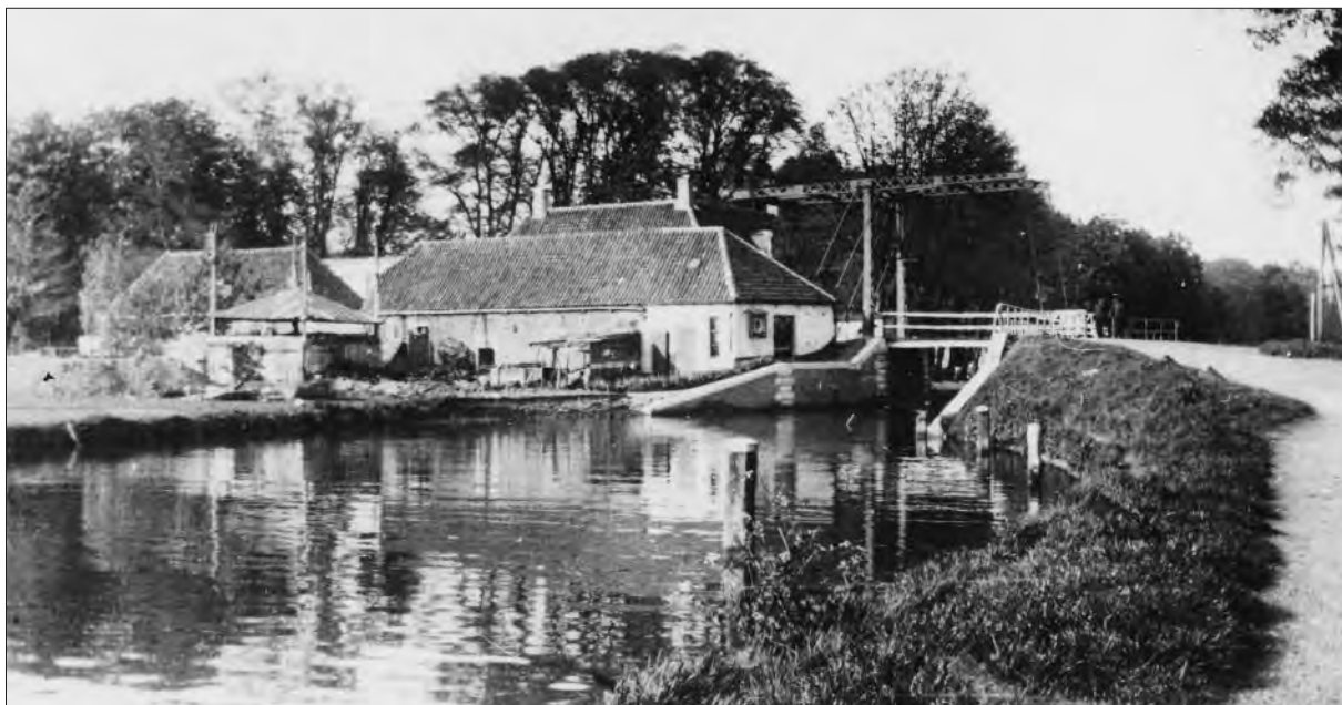
De Wijkerbrug met daarnaast de nog complete 'Boerderij bij de Wijkerbrug'. Het huidige brugwachtershuisje is het goed terug te herkennen achter de vermaarde uitspanning 'De Wijkerbrug' te zien.
