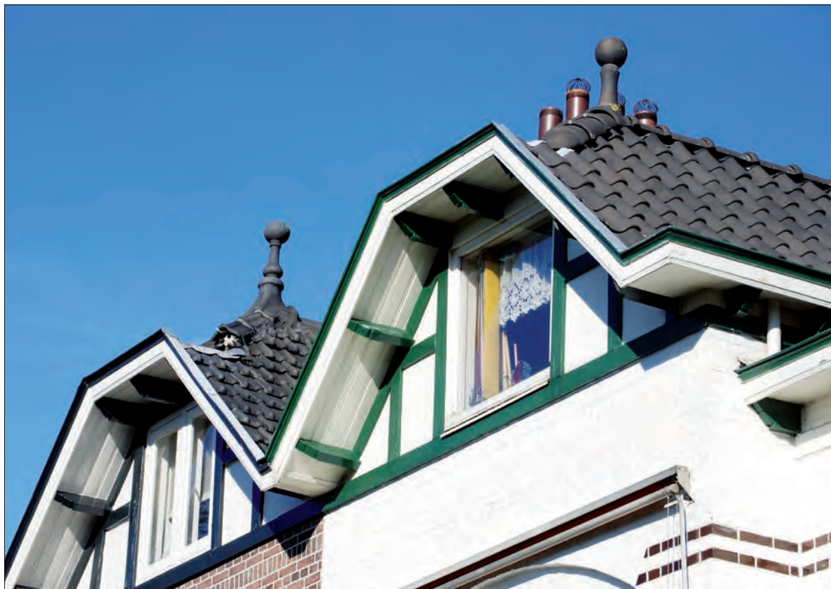
Bolvormige klassieke pironen op het dak van de nummers 27 en 29. Foto Joost van Kasteren
