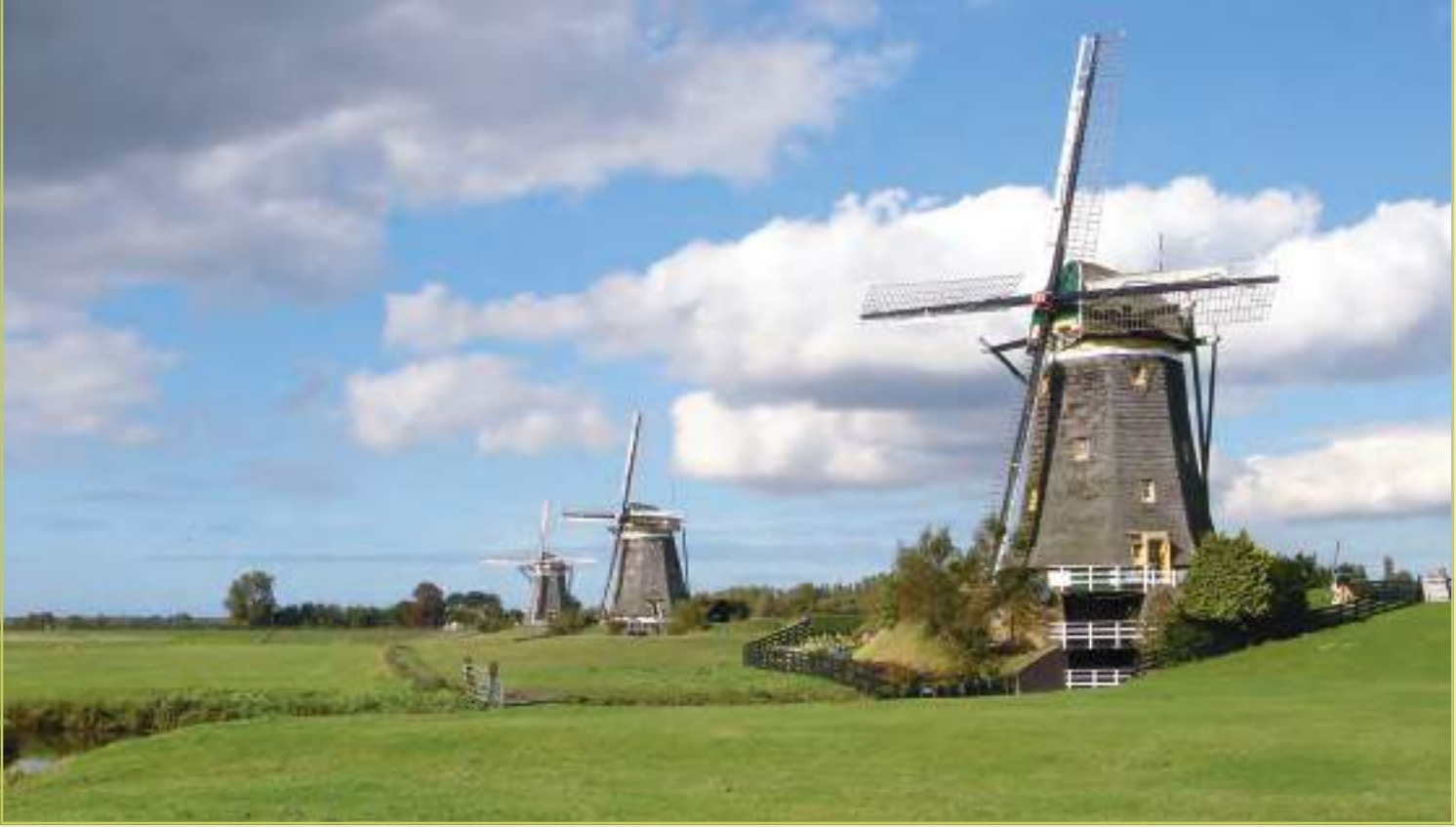
■ De overgebleven molendriegang van Stompwijk. Door de molens achter elkaar te plaatsen kon het water naar een steeds hoger niveau worden gemalen. De molens zijn bovenkruiers, de kap met het wiekenkruis is beweegbaar met behulp van een kruirad aan de buitenkant. Foto Kees van der Leer, 2008
