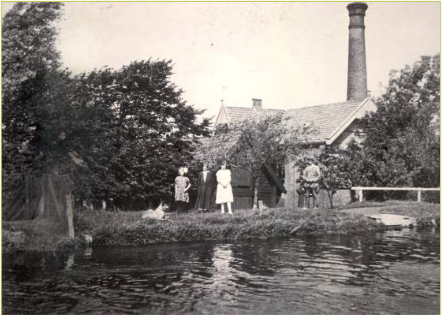
■ Het oude gemaal De Antagonist aan de Stompwijkseweg. Het stoomgemaal bemaalde de Starrevaart- en Damhouderpolder, waarbij het water via de Stompwijkse Vaart op de Vliet werd geloosd. In 1998 werd dit gemaal, dat inmiddels van een dieselmotor was voorzien, buiten gebruik gesteld. Bij calamiteiten kan het echter nog steeds worden ingezet. Foto, 1930. Collectie Gemeentearchief Leidschendam-Voorburg
