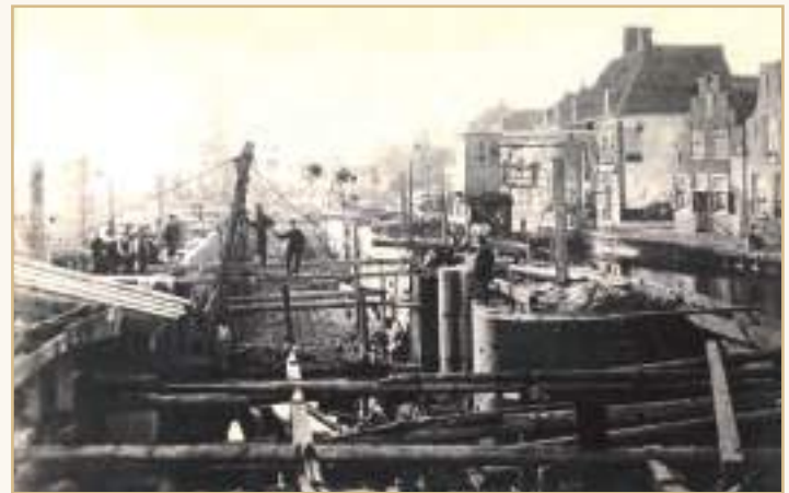
■ De aanleg van de nieuwe sluizen te Leidschendam in 1886. Foto collectie Gemeentearchief Leidschendam-Voorburg
