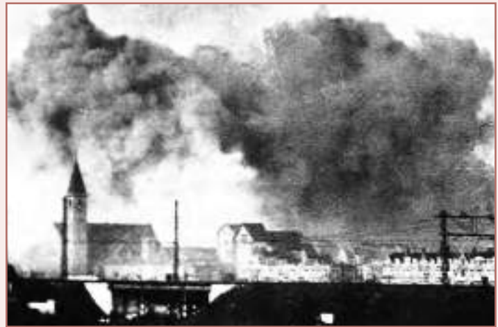
■ Het Bezuidenhout staat in brand, na het bombardement op zaterdag 3 maart 1945. Op de voorgrond het spoorviaduct bij de Laan van Nieuw Oosteinde. Foto, 1945. Collectie A. de Wolf
