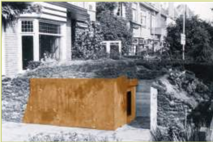
■ Schuilkelder in de tuin van de Van Deventerlaan 51, gebouwd in 1939. Foto particuliere collectie
