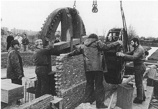
Plaatsing van het onderwiel en de onderas in de wielbak, 1990. Foto D. W. van den Eng
