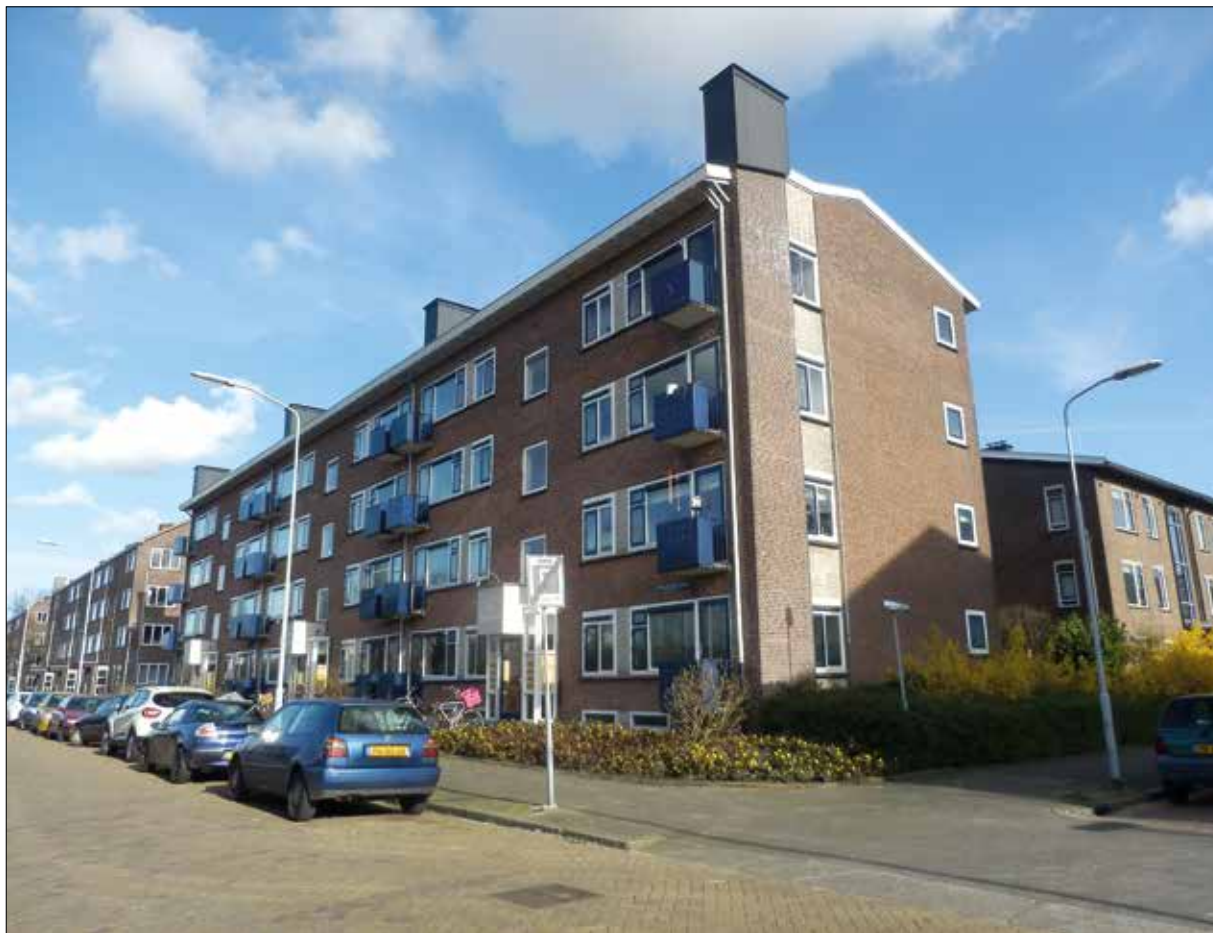
Flatgebouw, Douwes Dekkerstraat-Nicolaas Beetslaan. Foto auteur
