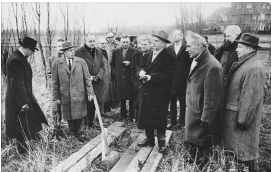
Bij het slaan van de eerste piketpaal, 3 januari 1962. Onder de aanwezigen onder meer: architect Rein Fledderus en de heren Mak, Versteegh, Vroegop, Zijlstra, Brouwer, Reinking, Visser, Van Leeuwen, ds. Lietaert Peerbolte, Kraayeveld, Van Deventer, Roggeveen, De Groot en Marcusse.
