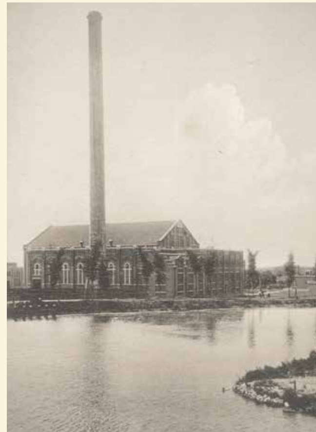
1.89 De Electricische Centrale aan de Westvlietweg, speciaal gebouwd voor de Hofpleintrein, die als eerste in Nederland geheel op elektriciteit reed. De hoge, 60 meter hoge schoorsteen werd, voor het eerst in Nederland, geheel in gewapend beton uitgevoerd. Nadat was overgeschakeld op wisselstroom werd in 1927 de schoorsteen afgebroken. De Centrale werd werkplaats en remise. Ansichtkaart, begin twintigste eeuw. Collectie auteur
