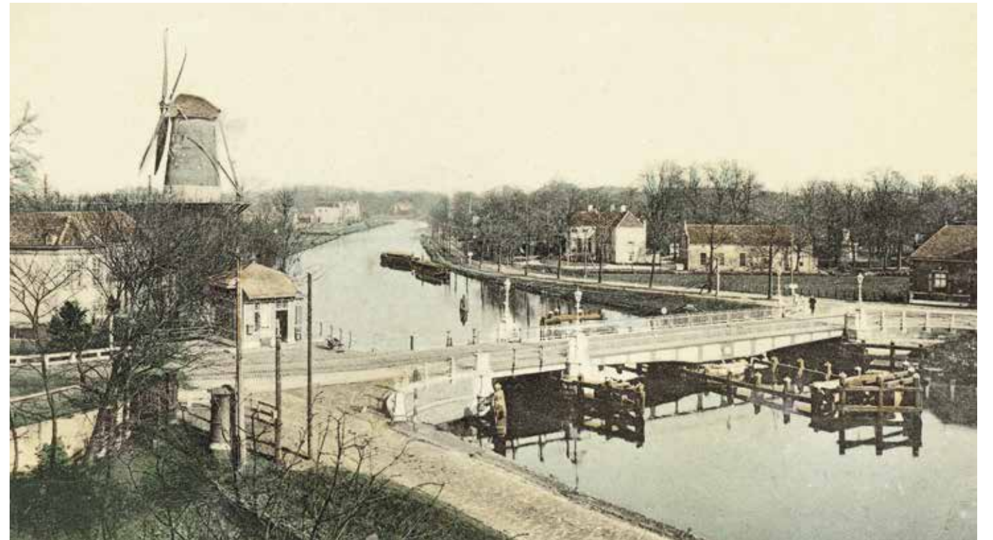
3.68 De Hoornbrug, in 1893 in gebruik genomen als ijzeren draaibrug. Rechts Hoornwijk en links het brugwachtershuisje met daarachter de Korenmolen met uitspanning Het Molentje . Ansichtkaart, begin twintigste eeuw. Collectie Stichting Hoekenburg
