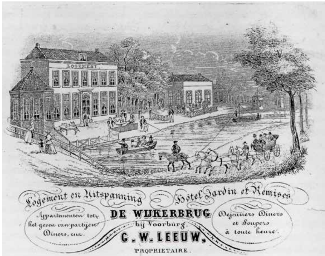
1.112 Reclamekaart van De Wijkerbrug . Rechts maakt een met vier paarden bespannen rijtuig vaart om de ietwat steile helling van de brug te halen. Collectie Gerard Duijvestein
