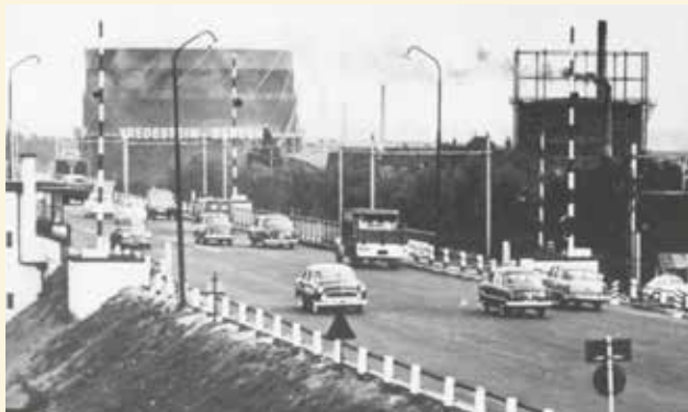
2.87 De twee gashouders van de Voorburgse gasfabriek bij de brug over de Vliet. Foto, begin twintigste eeuw. Collectie auteur
