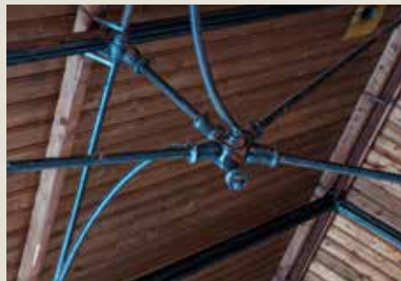
1.63 De gietijzeren Polonceau-spanten in de voormalige kas van Vreugd en Rust . Foto Ronald Meekel, 2019
