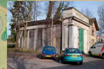
4.07 De orangerie van buitenplaats Weizigt te Dordrecht. Foto A. Speelman, 2010. Bron: kastelenhollandzeeland.nl
