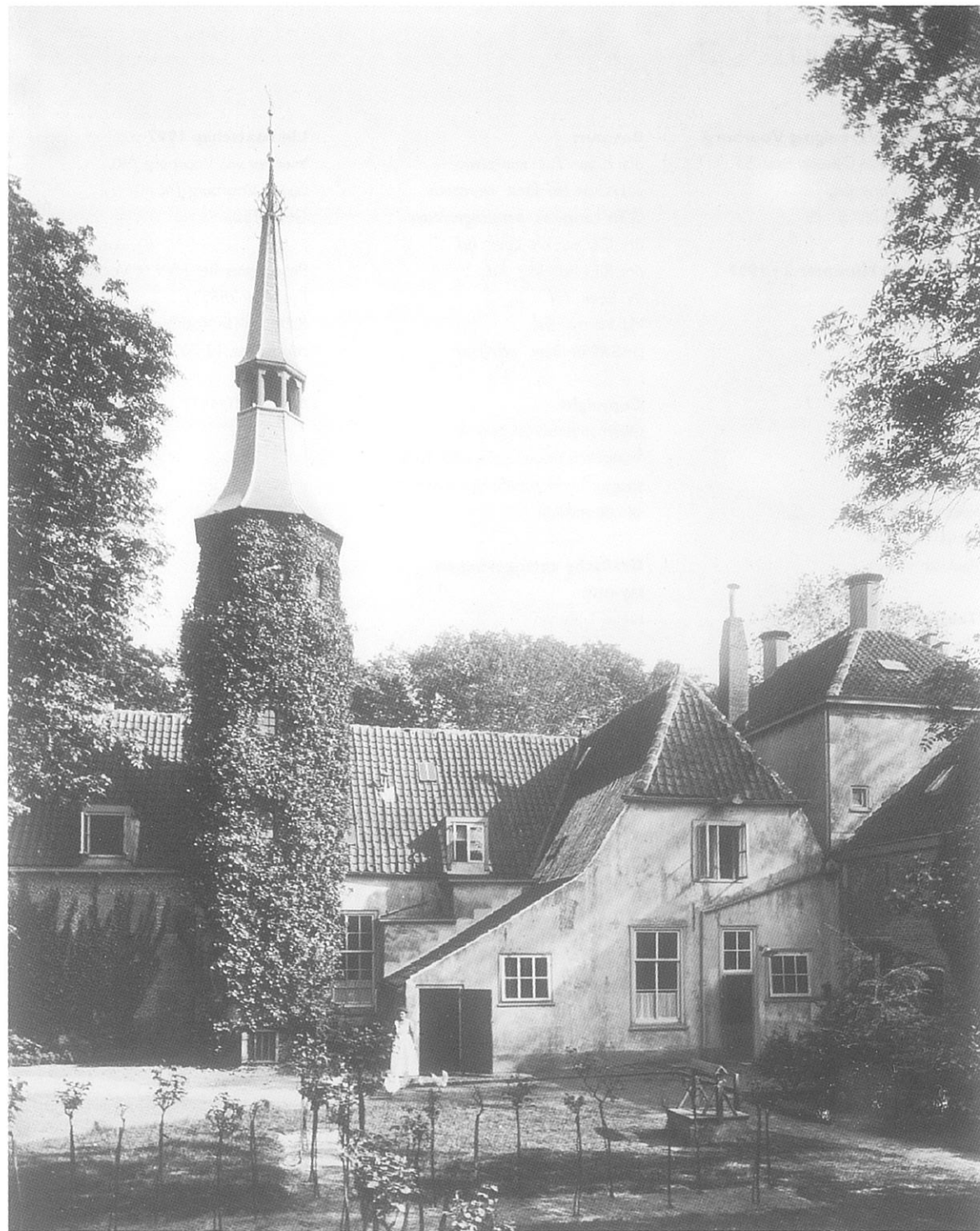
Huis de Werve omstreeks 1920, gefotografeerd vanaf de Prins van Lignestraat. Bij de latere restauraties is de aanbouw aan deze zijde van het gebouw afgebroken.
